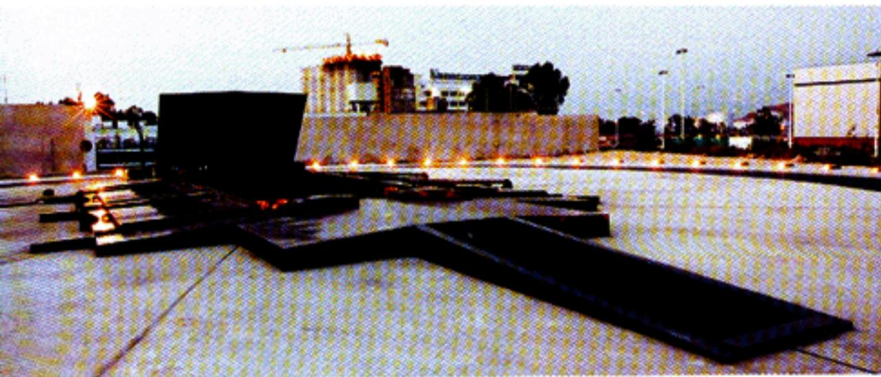
Bei Nacht werden die stählernen Abdeckhauben der Music-Hall beiseite geschoben, und der hydraulische Dachdeckel über der Bar fährt nach oben.
